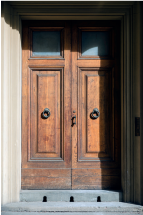
Dettaglio ingresso principale su via Cavour
