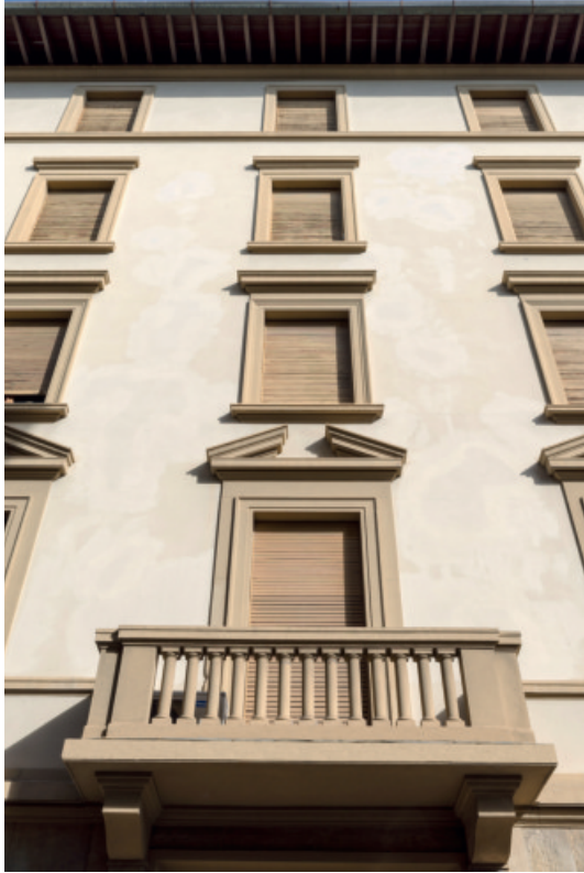
Dettaglio facciata su via Cavour
