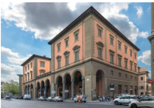
Palazzo Libertà è un imponente edificio ad angolo tra l'omonima piazza e via San Gallo. Ospita attività commerciali al piano terra e residenze ai piani superiori.
